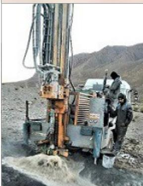
\* La réalisation de l'équipement d'irrigation à Aït Kharrou avance, après le creusement du forage à 100 m de profondeur exécuté en une seule nuit
