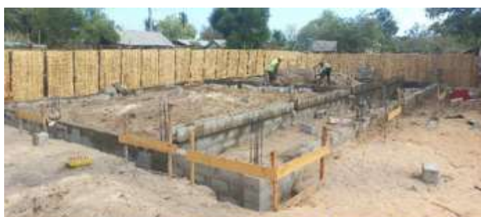
Avancement du chantier
