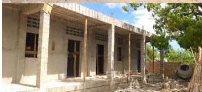
Etat du chantier au 15 janvier 2026
