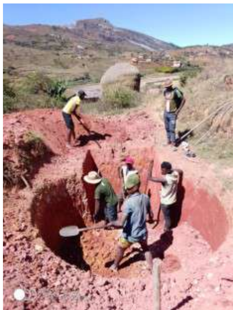
Réalisation de la fouille devant recevoir le bio-digesteur
