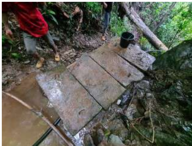
Vétusté des installations existantes
