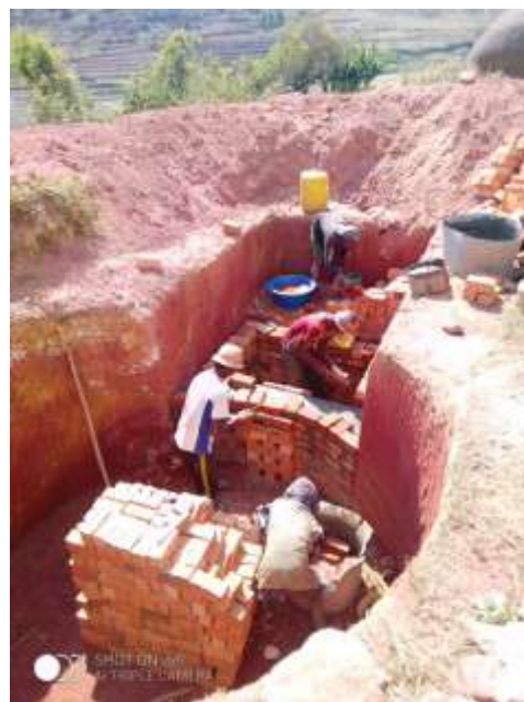
Construction de la partie maçonnée pour recevoir le digestat
