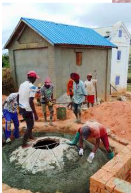
Coulage du béton chez Stanislas
