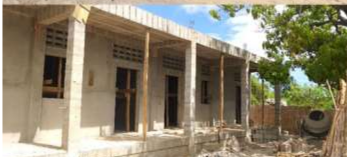
Etat du chantier au 15 janvier 2026
