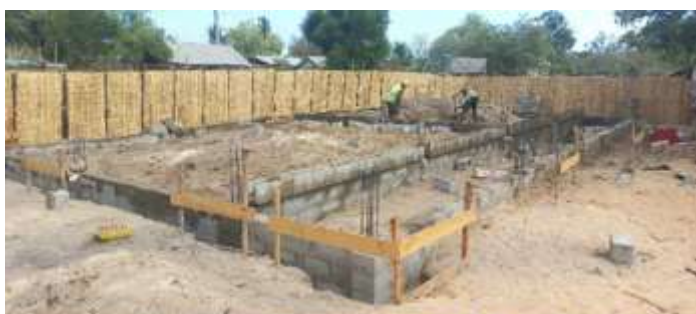
Avancement du chantier
