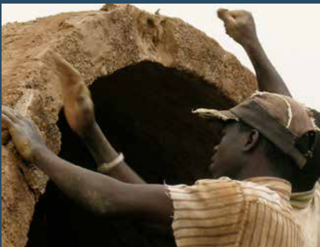
© La Voûte nubienne
